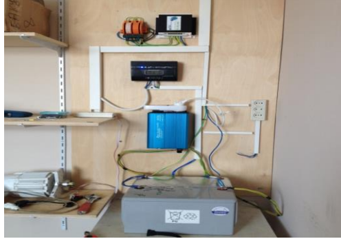
Kontrollerlə idarəetmə sistemi
